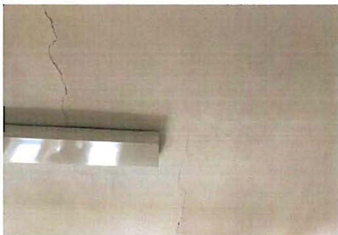
Slika 1. Karakteristično oštećenje: Plafonska obloga je dotrajala, ima ugibe i sklona je padu.
