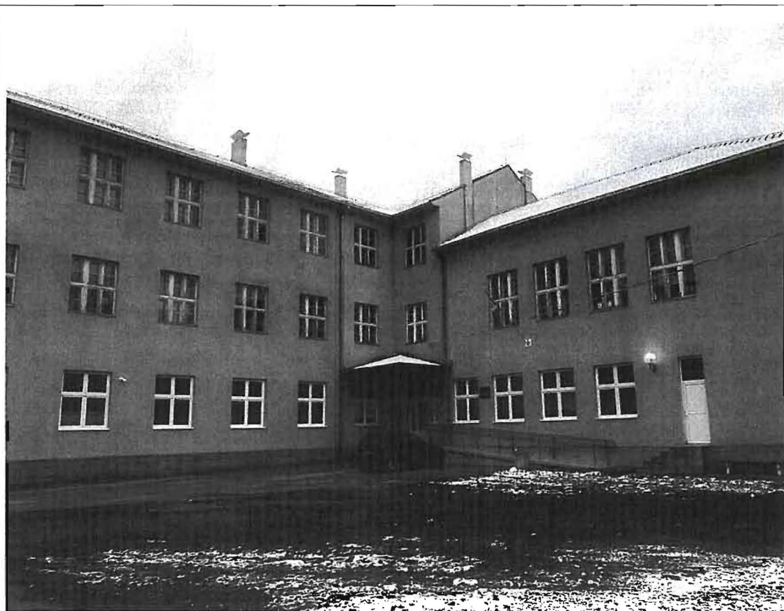
Фотографије фасада објекта
