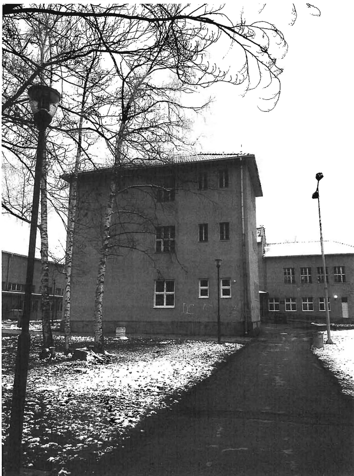
Фотографије фасада објекта
