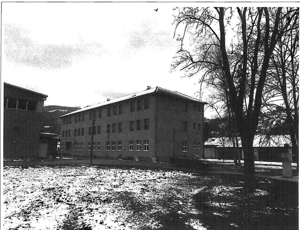
Фотографије фасада објекта
